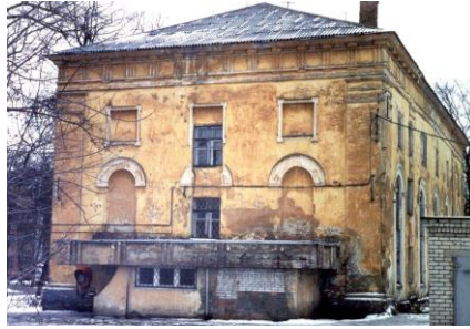
Рисунок 3. Евангелическо-лютеранская церковь. Северный фасад (1999 г.) с пристройкой (фото автора)
